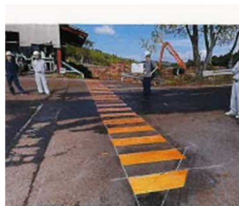
（共販所土場作業エリア線引）
