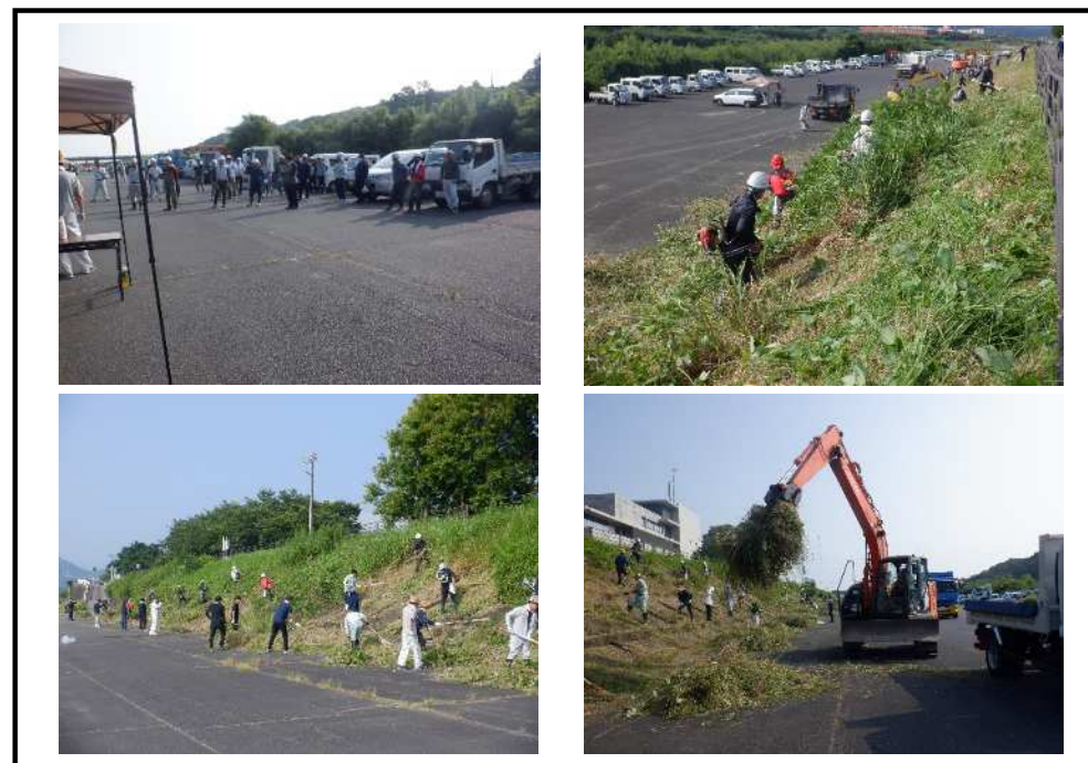
【駅館川河川清掃 作業状況】
