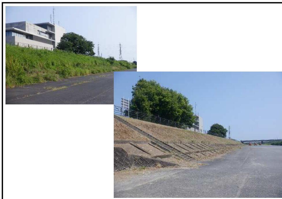
【駅館川河川清掃 作業前、作業後】
