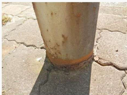
平成30年点検時基部状況
