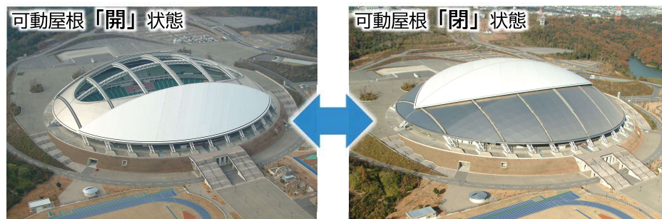
大分スポーツ公園総合競技場
