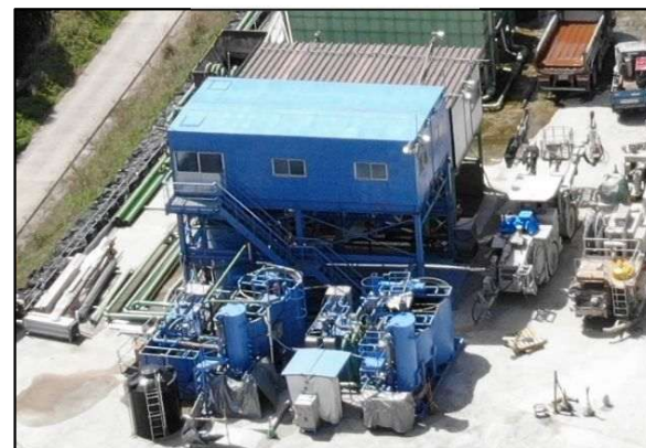
▲ ①-3 濁水処理施設増設
