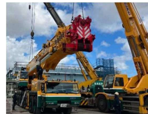
クレーン組立の状況
