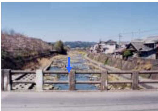
写真 17 武蔵川の下流部の景観 (平成 12 年 4 月撮影)
