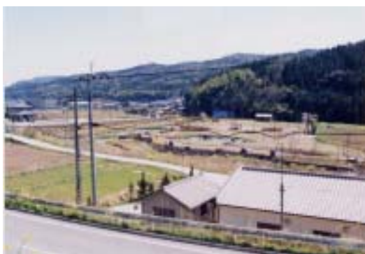
写真 13 河川公園周辺 (平成 12 年 4 月撮影)
