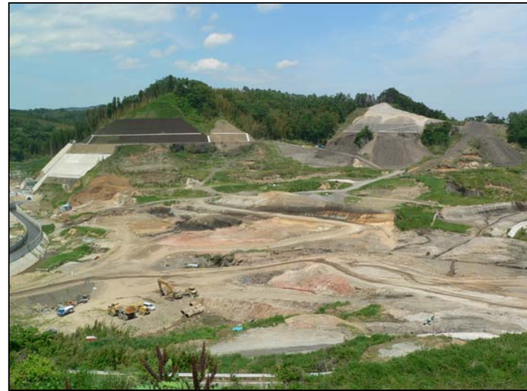
貯水池対策工事 撮影日:平成17年5月25日(掘削状況)
