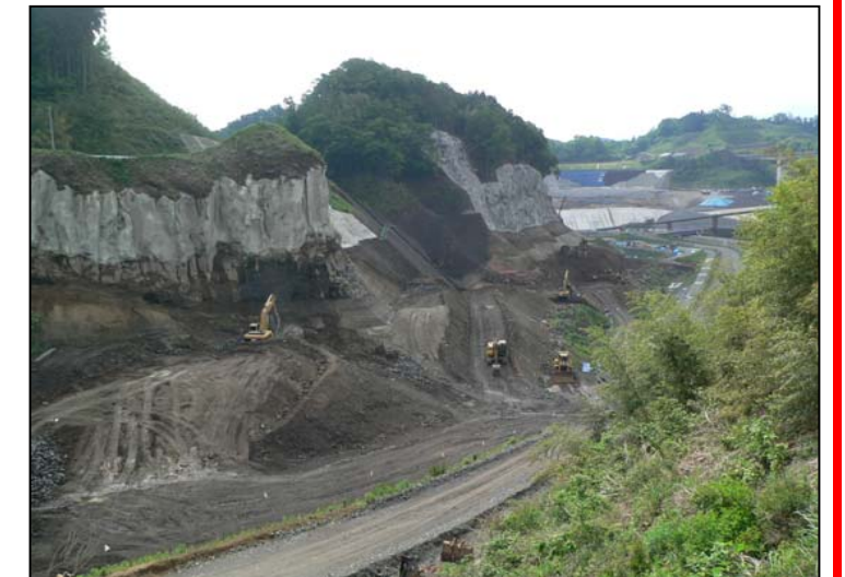
貯水池対策工事 撮影日:平成19年7月19日
