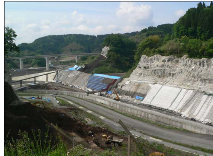
貯水池対策工事 撮影日:平成19年7月19日
