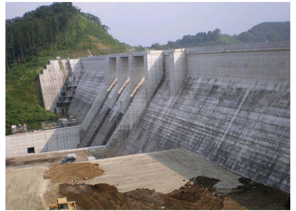
稲葉ダム本体工事 撮影日:平成19年7月19日
