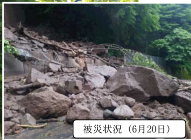
① 河内橋下流 (九酔溪入り口付近) 崩壊規模 高さ 80m 被災道路延長 20m
