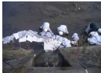
【職員による倒木処理やオイルマット設置状況】
