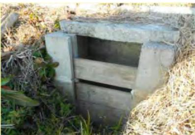
排水口への堰板の設置
