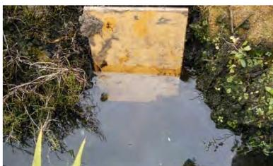
止水板による止水状況
