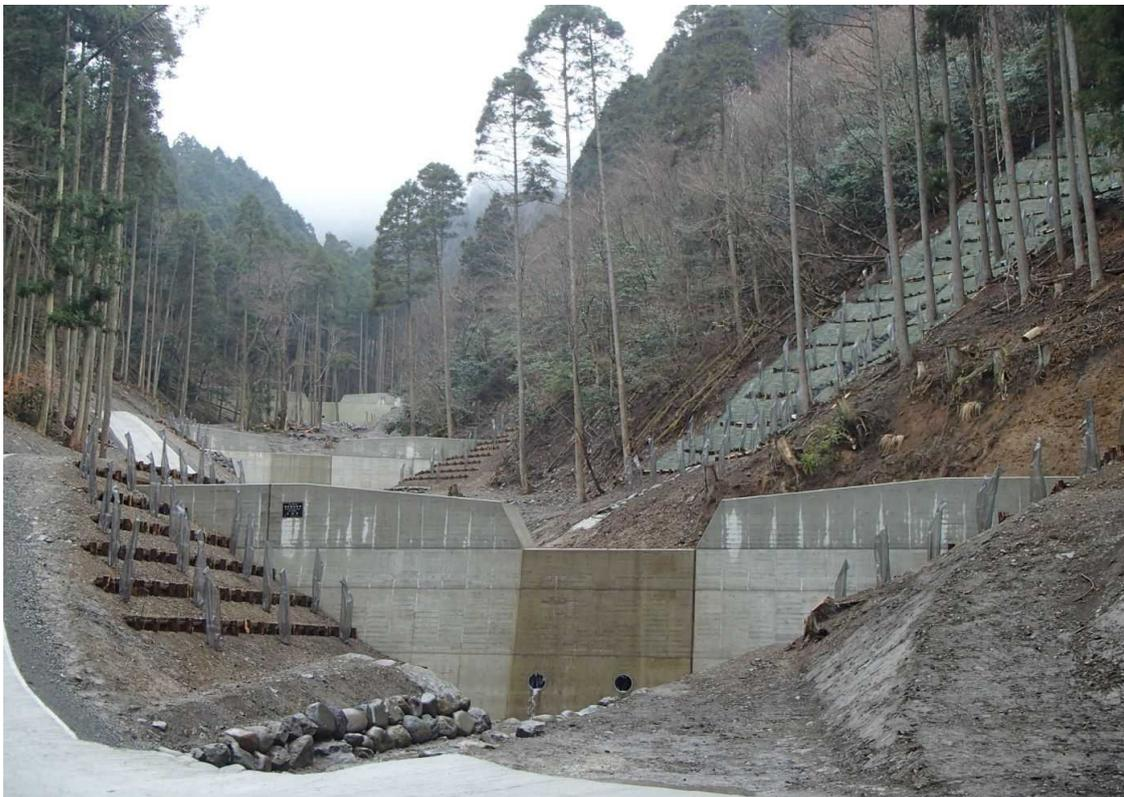
土砂の流出を防止する治山ダムと、崩壊地復旧のため苗木の植栽を実施
