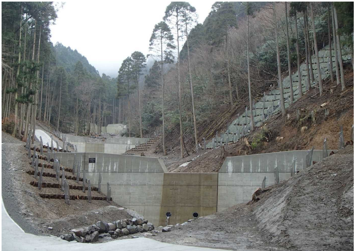
土砂の流出を防止する治山ダムと、崩壊地復旧のため苗木の植栽を実施 (復旧治山事業 不動口B溪地区 中津市山国町小屋川)
