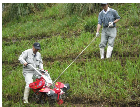
写真1 歩行型管理機による作業道造成作業
