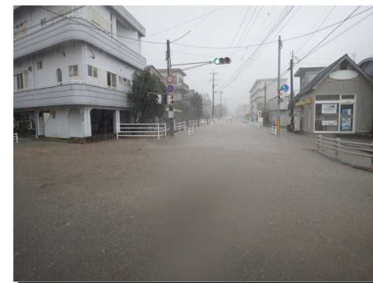
平成29年9月17日台風18号による内水被害
