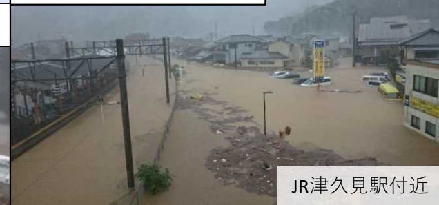
被災状況 (H29.10)
