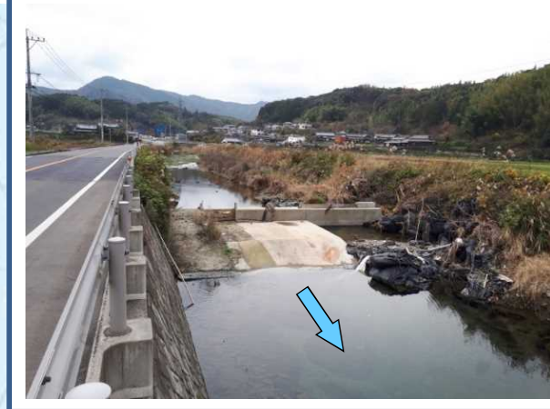
熊崎川(整備中写真)
