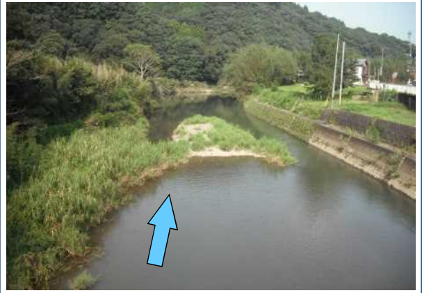
臼杵川(今後整備区間)
