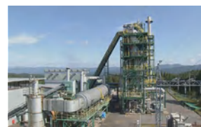
木質バイオマス発電所（日田市）
