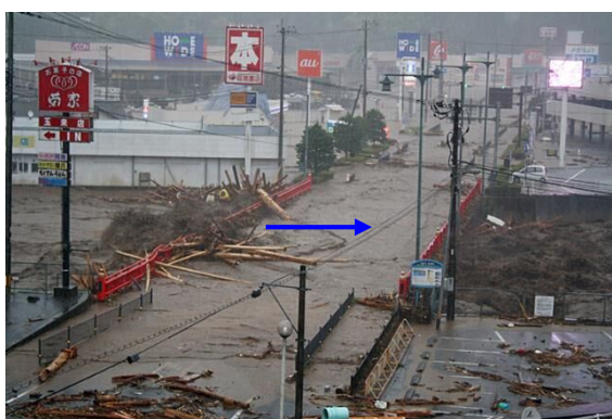
玉来川出水状況(竹田市大字玉来、桜瀬橋付近)
