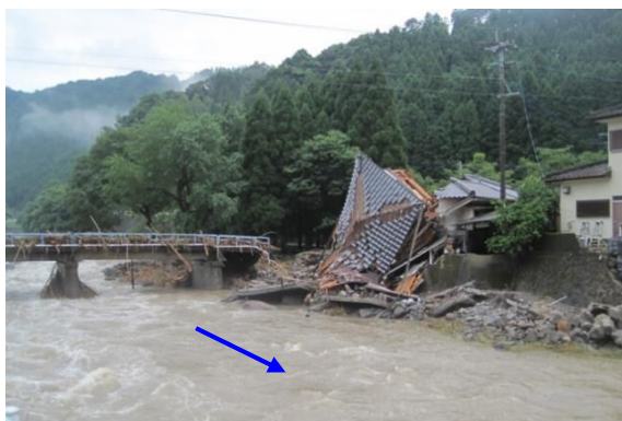
花月川被災状況(日田市大字花月)
