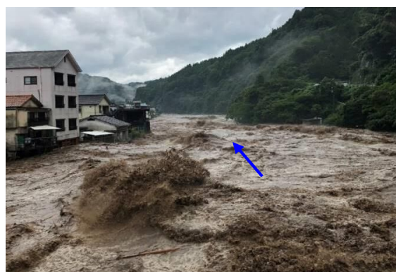
玖珠川出水状況(日田市天ヶ瀬町湯山、新湯山橋)
