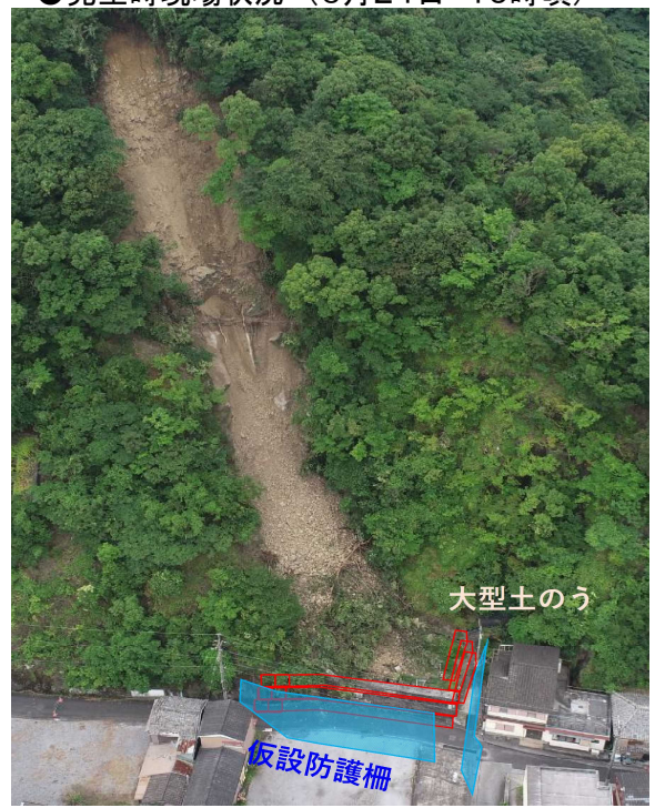
●発生時現場状況（6月24日 10時頃）
