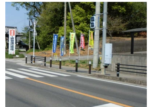
国道213号（豊後高田市） ガードパイプ・車止め設置
