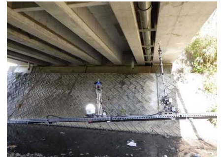
点検支援ロボットによる 橋梁点検状況 中判田犬飼線 犬飼橋側道橋 （豊後大野市）
