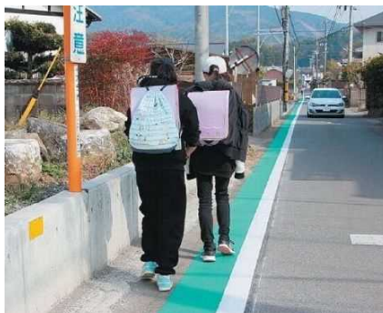
臼杵大南線（大分市戸次） グリーンベルト設置
