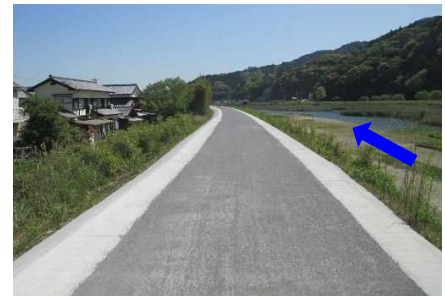
堤防天端の舗装
