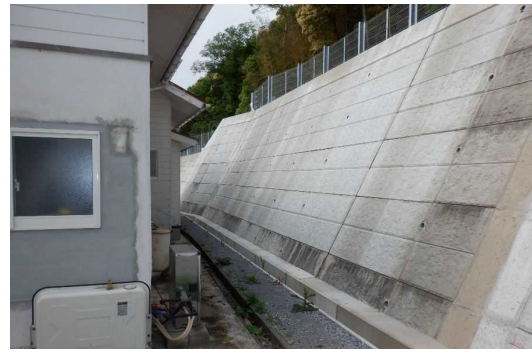
急傾斜地崩壊対策事業 平ノ下地区（豊後高田市）
