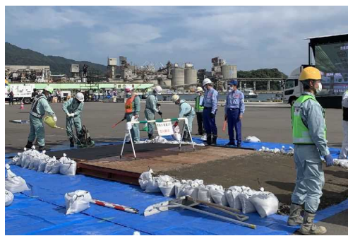
(緊急補修による路面段差解消訓練)
