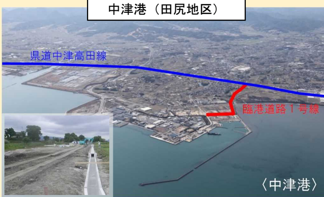
令和3年度実施 道路改良工
