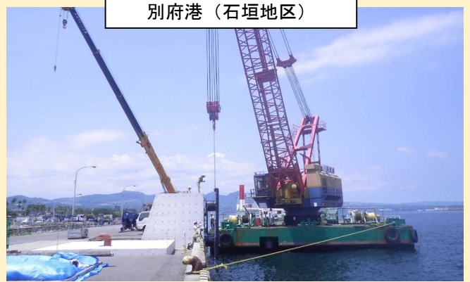
令和3年度実施 防衝板設置
