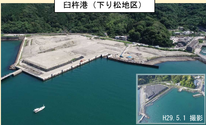
令和3年度実施 岸壁及び埠頭用地造成工
