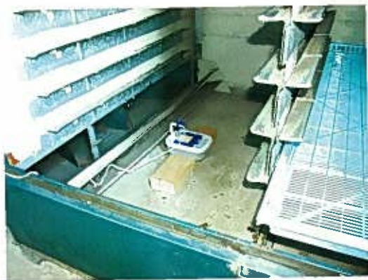
写真2 乾燥機内設置状況
