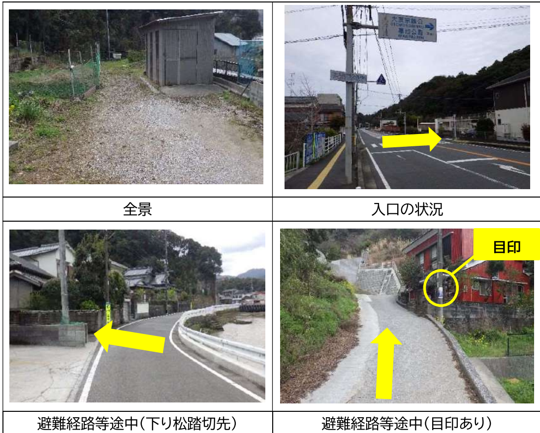
写真1 避難施設等の状況
