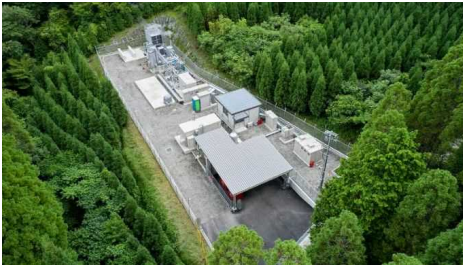
地熱発電による水素製造 (大林組) R3~R5年度
