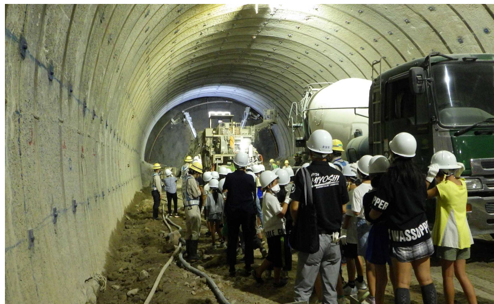
トンネル坑内見学
