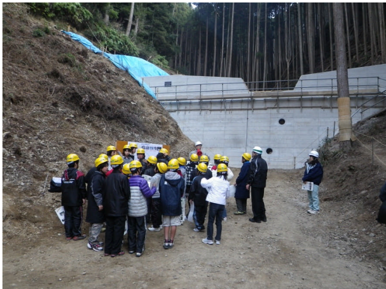
現地学習(施工中工事現場にて)
