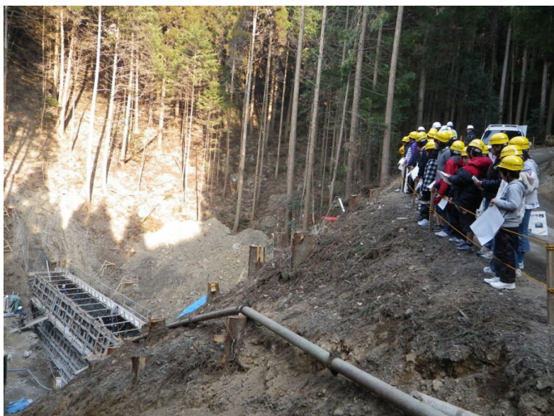
現地学習(施工中工事現場にて)
