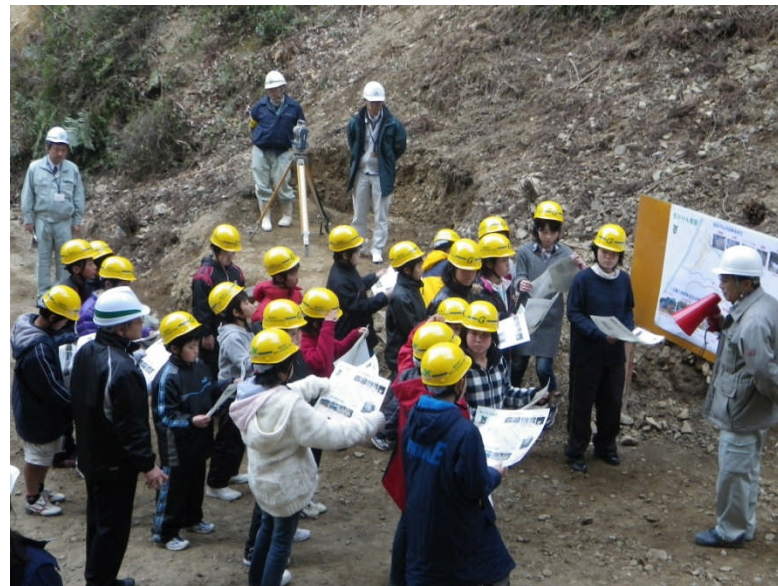
現地学習(施工中工事現場にて)
