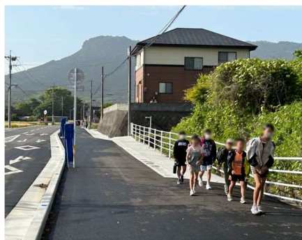
渋見成恒中津線（中津市） 歩行者道整備
