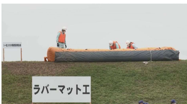
(ラバーマット工)
