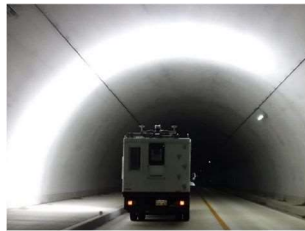
トンネル点検状況 国道212号 ひびきトンネル (日田市)
