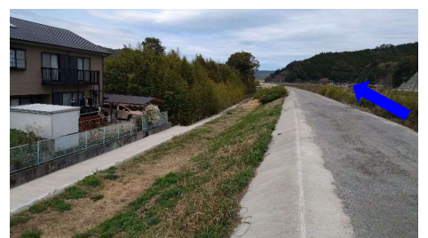
堤防天端の舗装
