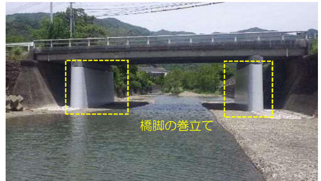
耐震補強の事例（国道388号 芹川橋）
