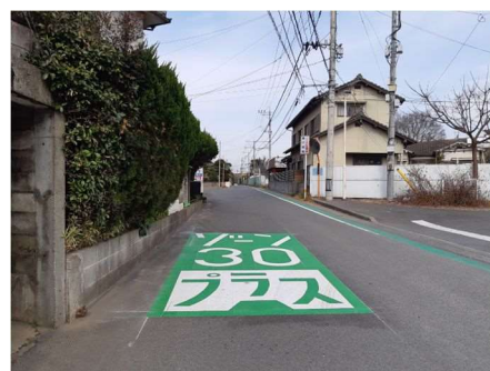
ゾーン30プラス(大分市中戸次) 路面標示設置
