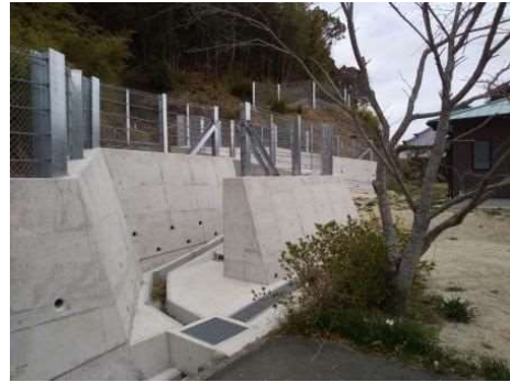
急傾斜地崩壊対策事業 小猪尾地区（杵築市）
