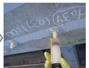
橋梁の補修状況 国道387号 白岩橋 (宇佐市)
