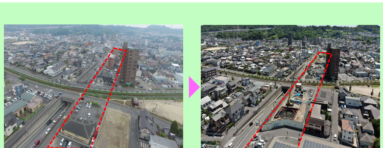
令和元年5月 令和5年3月 （都）庄の原佐野線（下郡工区） 工事状況
