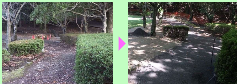
改修前 改修後 高尾山自然公園 園路のバリアフリー化
