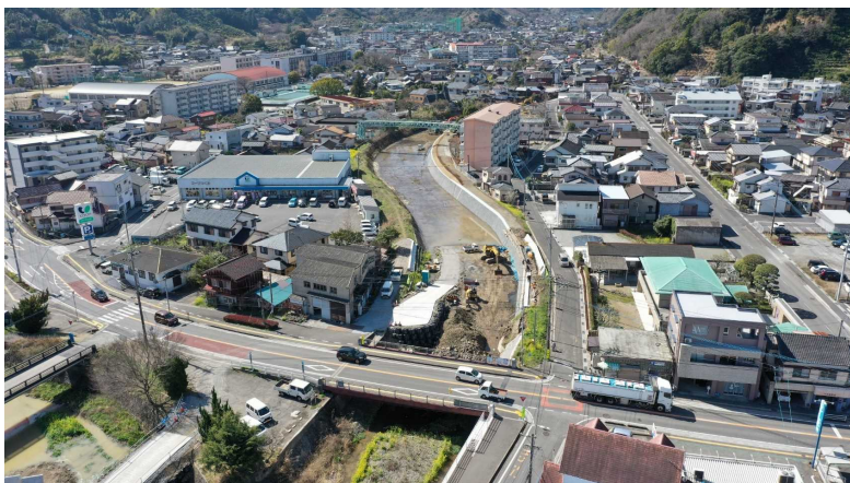
【八幡橋上流付近】
