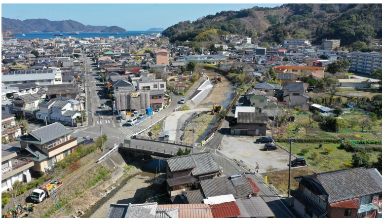
【中田橋下流付近】
