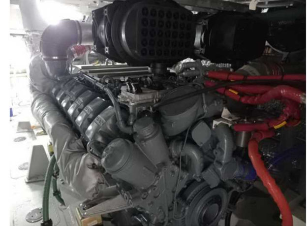
設置された主機
