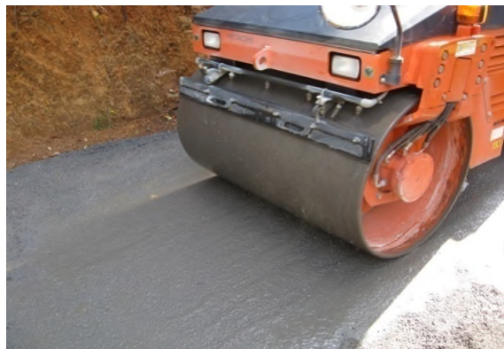
（鉄鋼スラグ敷設状況）
