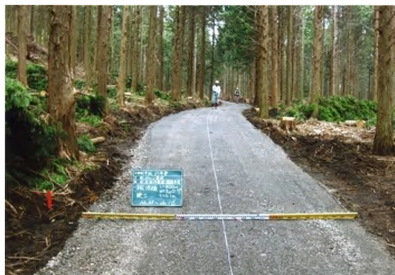
（鉄鋼スラグ路盤工：豊後大野市） ※周囲の山林を間伐している
