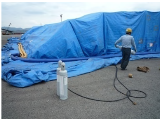
燻蒸作業状況
