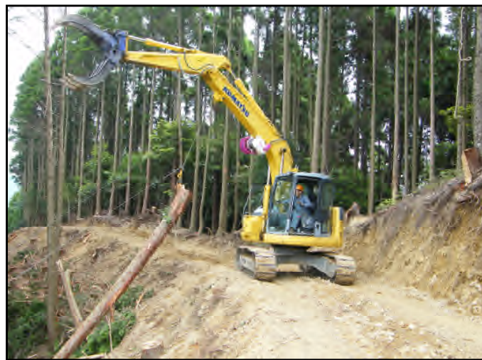
改良機械（スイングヤード）による集材状況
