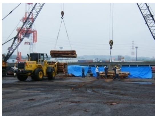
船積作業状況
