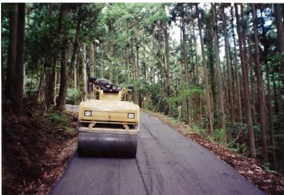
（鉄鋼スラグ敷設状況）
