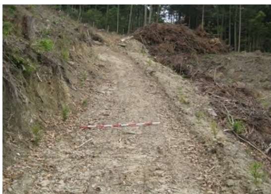
(作業路：中津市)
