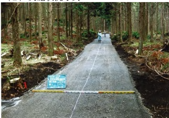
（鉄鋼スラグ路盤工：豊後大野市） ※周囲の山林を間伐している
