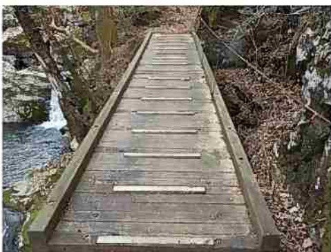
九州自然歩道木橋整備
