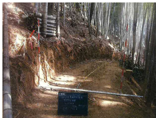
簡易作業路の開設
