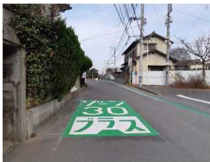
ゾーン30プラス(大分市中戸次) 路面標示設置
