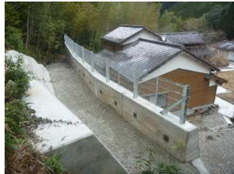
急傾斜地崩壊対策事業 2号市福所地区（佐伯市）
