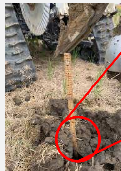
排水口は明渠の深さまで掘り下げる
