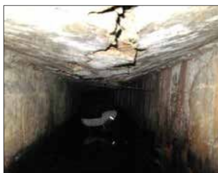
隧道の亀裂
