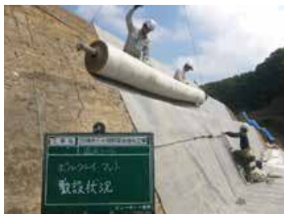
遮水シート工法による全面改修
