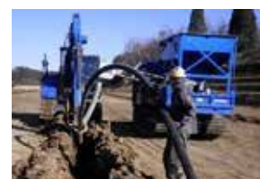
FOEAS施工状況
