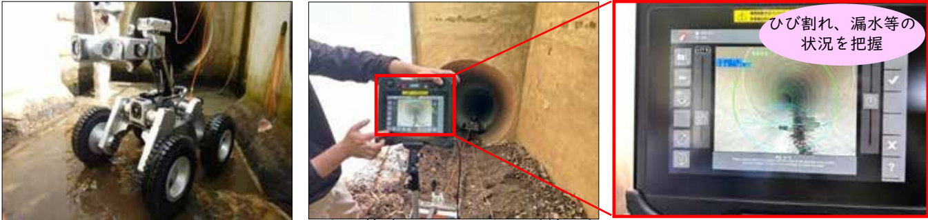
小型管内カメラによる近接目視
