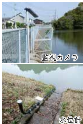
監視カメラ・水位計の整備
