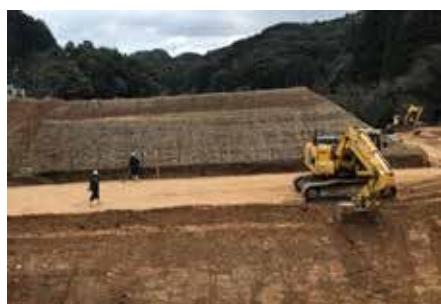
前刃金工法による全面改修
