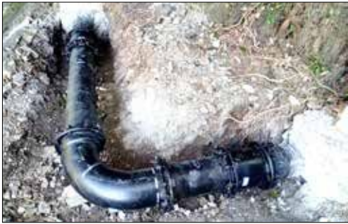
パイプラインの早期復旧
