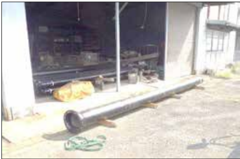
スペア資材の備蓄
