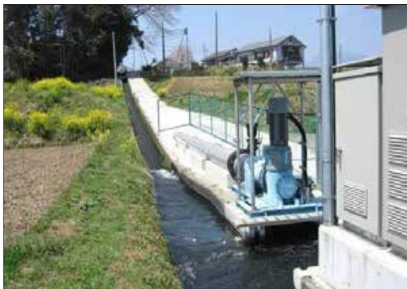
小水力発電施設
