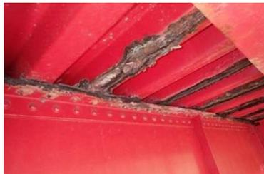
鋼桁 防食機能の劣化・腐食
