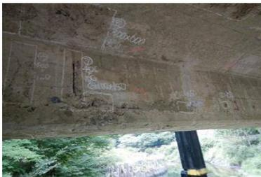
RC 主桁 剥離・鉄筋露出
