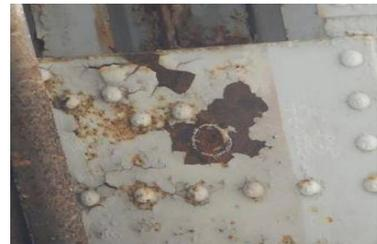
鋼桁 ゆるみ・脱落
