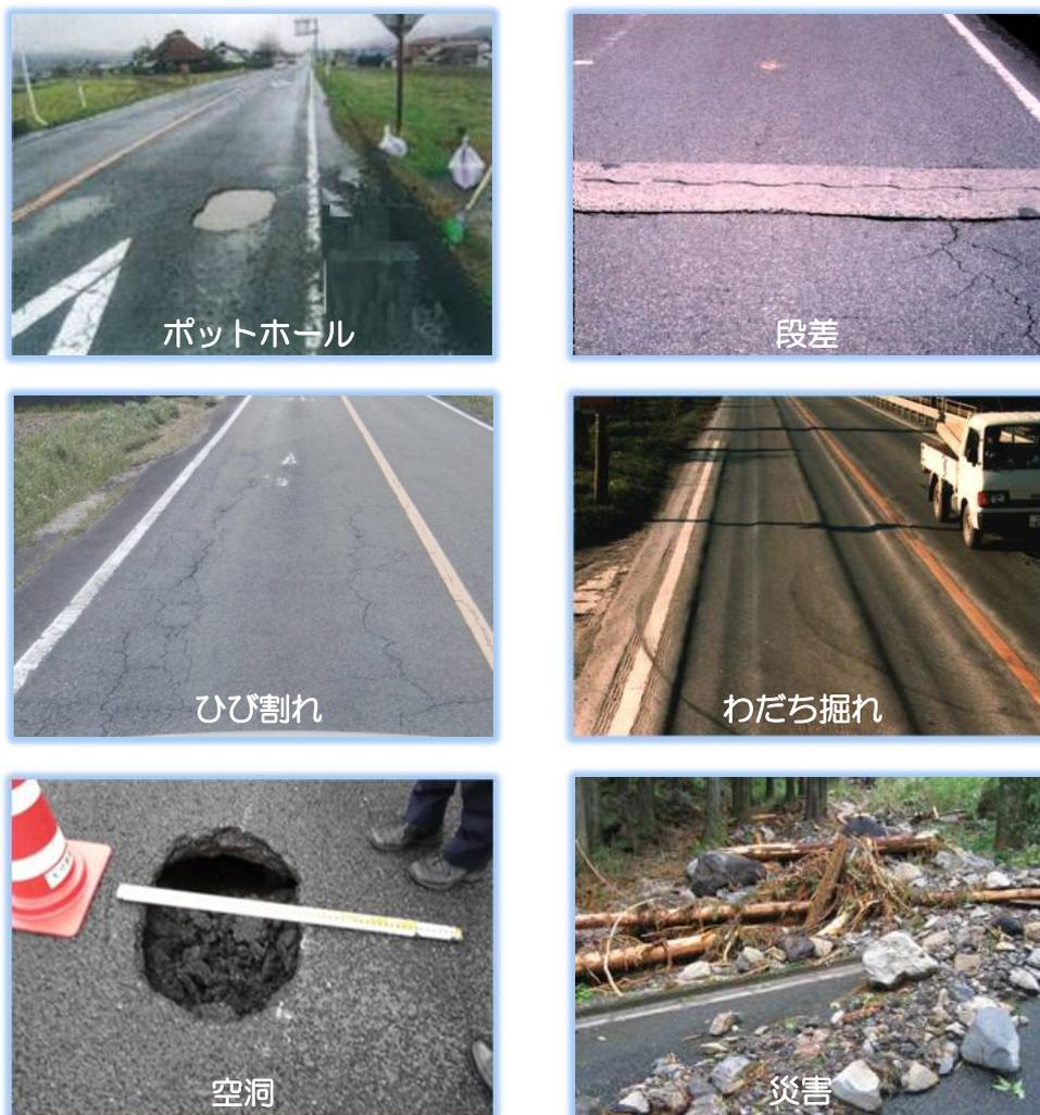
図-2.4 舗装の点検状況
