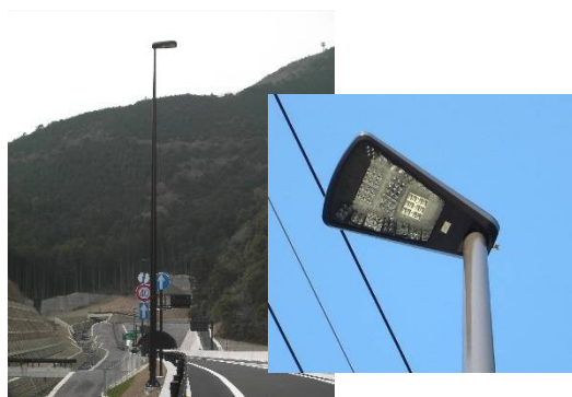
LED ライトの設置状況
