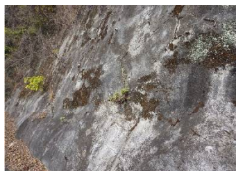
【モルタル・コンクリート吹付】
