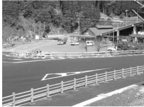
木製ガードレール設置状況
