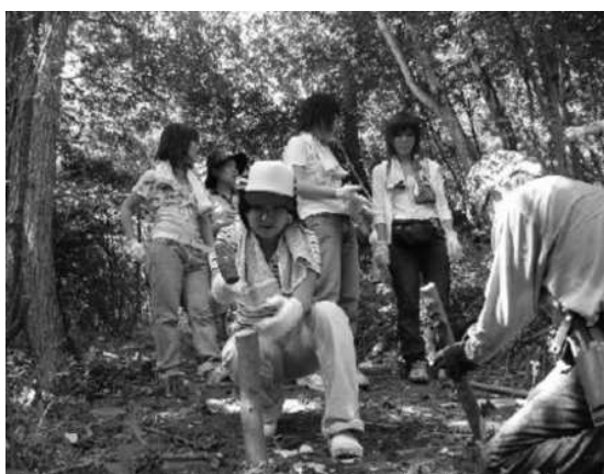
遊歩道設置状況
