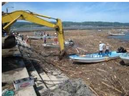
流木回収作業
