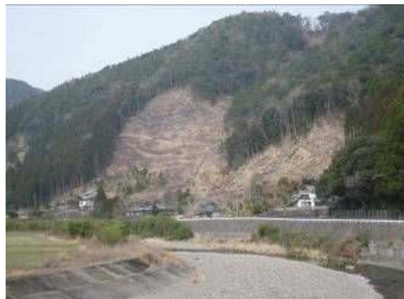
再造林放棄地緊急整備事業（完了後）
