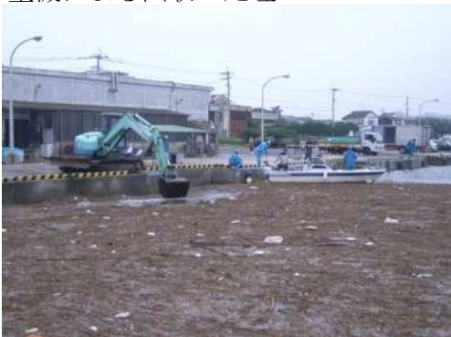
重機による回収・処理
