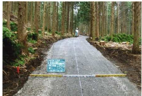
（鉄鋼スラグ路盤工：豊後大野市） ※周囲の山林を間伐している
