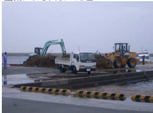
重機による回収・処理
