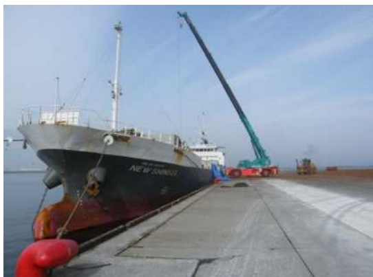
船積作業状況
