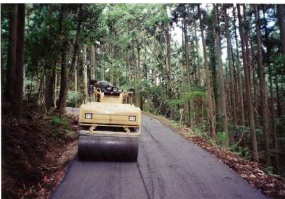
（鉄鋼スラグ敷設状況）
