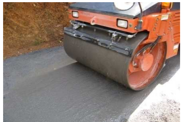
（鉄鋼スラグ敷設状況）
