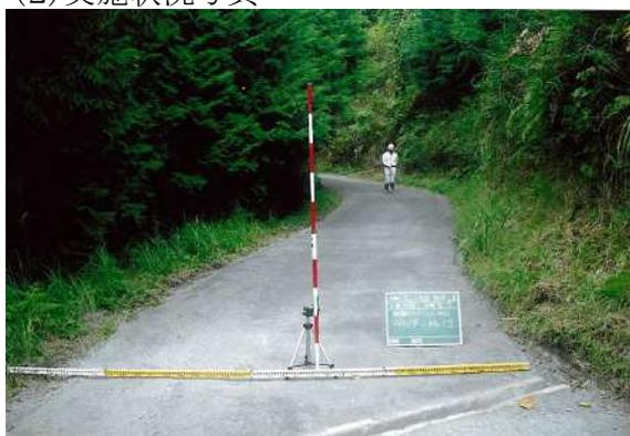
(鉄鋼スラグ路盤工:日田市)
