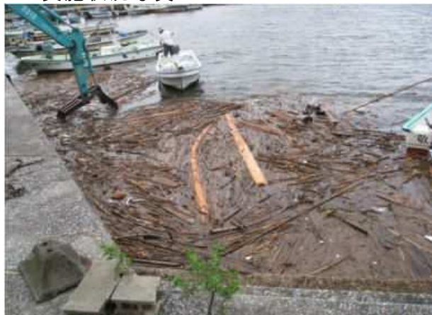
日出町豊岡漁港での回収状況
