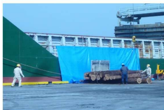
在来船への積み込み状況
