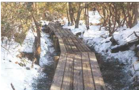
九州自然歩道木道整備
