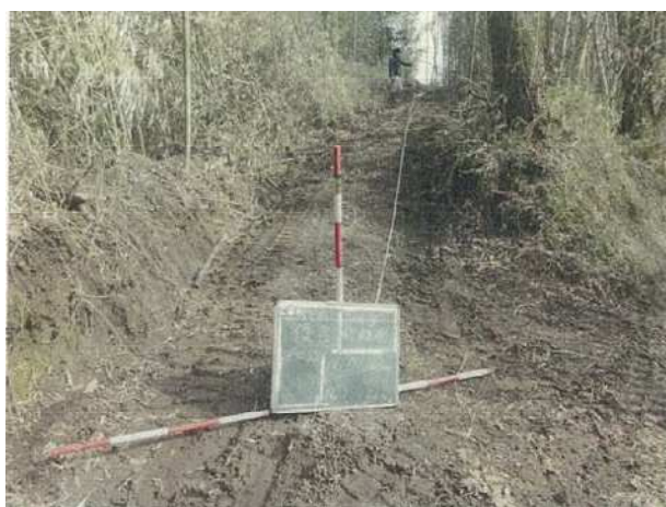
【簡易作業路の開設状況】
