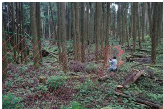
鹿ネット設置
