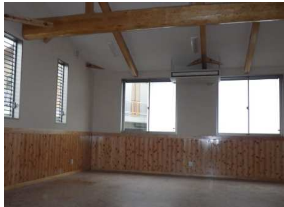
【内部：腰壁・造作材（杉材）】
