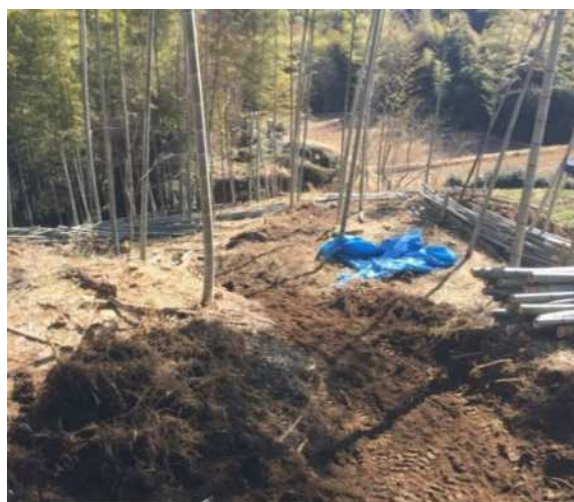
【簡易作業路の開設状況】
