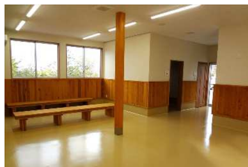
CLT により整備した待合室
