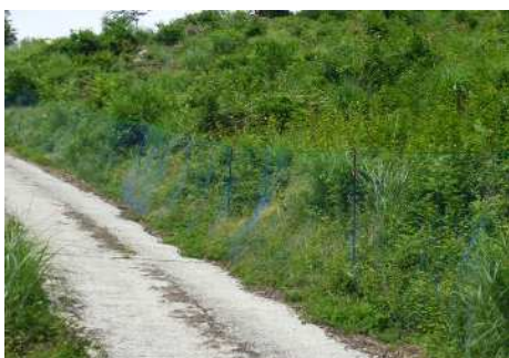
写真－1 簡易ネットの設置例
