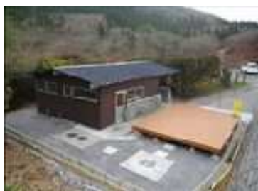
万年山避難小屋トイレ
