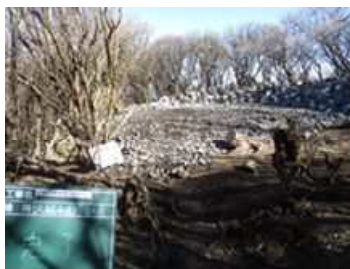
大船山避難小屋撤去
