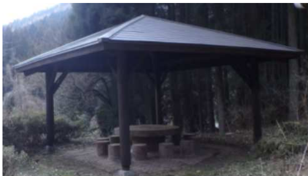
九州自然歩道 東屋改修
