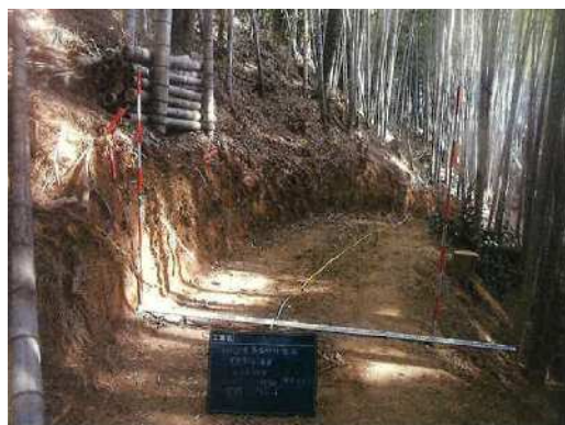
簡易作業路の開設
