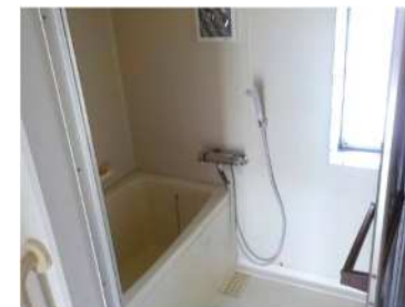
給湯設備やシャワー水栓を設置
