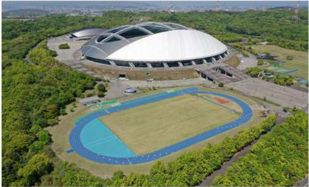
○平成13年5月設置
