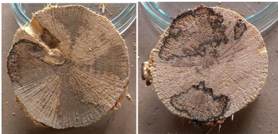
写真1 R 4 年度試験ほだ木断面状況 (10/20 左：対照区 右：早期被覆区)
